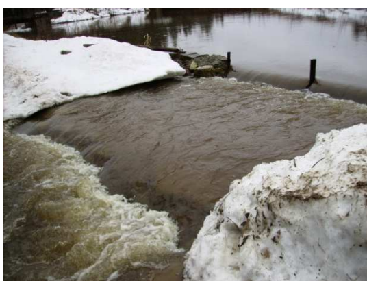
5. att. Esošais pārplūdes sliekšnis (derivācijas kanālā paaugstināts ūdens līmenis) Avots: autora personīgais arhīvs
