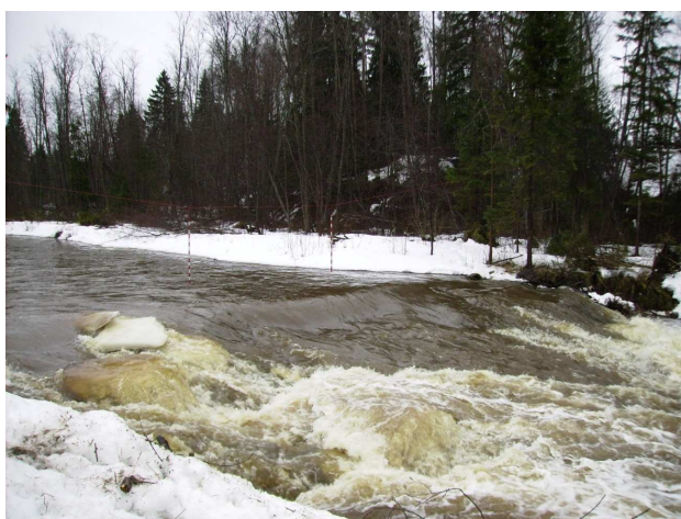
4. att. Akmeņu bēruma sliekšnis ar kalibrētu pārgāzni 2010.gada 28. martā.
