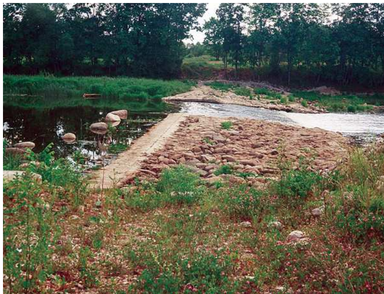
9.att. Akmens bēruma sliekšnis neilgi pēc izbūves. Skats no labā krasta. Avots: Mazās hidroenerģētikas asociācija
