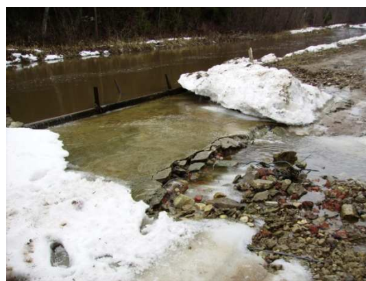
6.att. Esošais pārplūdes sliekšnis (derivācijas kanālā normāls ūdens līmenis) Avots: autora personīgais arhīvs
